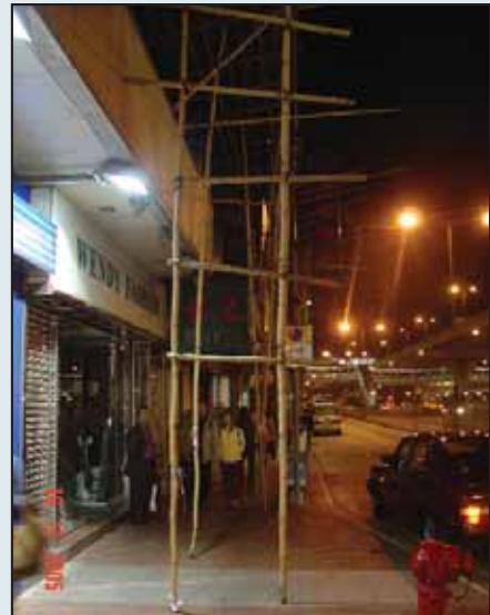
Resim 5: Hong Kong sokaklarında bir inşaatın yanından geçerken. Modern şehirde vazgeçilemeyen gelenekler: Bambu.
